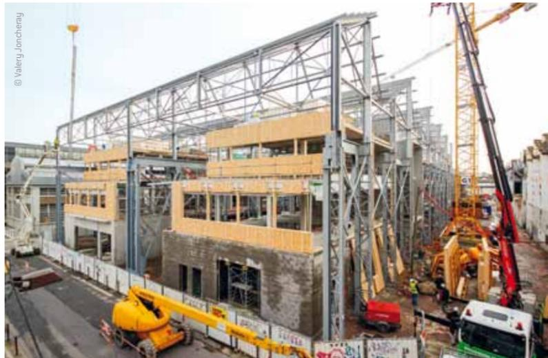
Avec la pose des charpentes de toit démarrée à l'automne 2015 sur le premier tronçon, suivie de la construction des premiers modules intérieurs, l'esprit architectural de la future école se dévoile.
