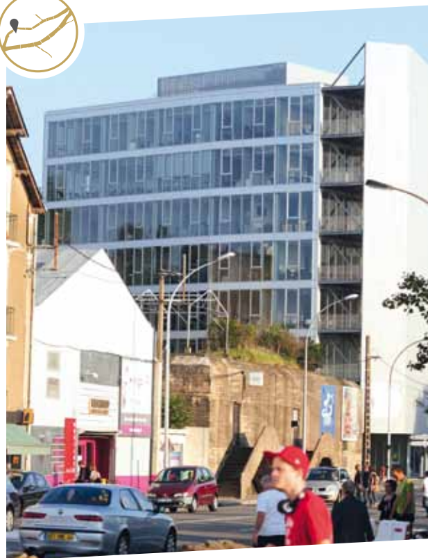
Avec 24 000 véhicules qui l'empruntent quotidiennement, le boulevard Léon-Bureau est un axe sensible autant qu'une fracture dans le tissu urbain.
