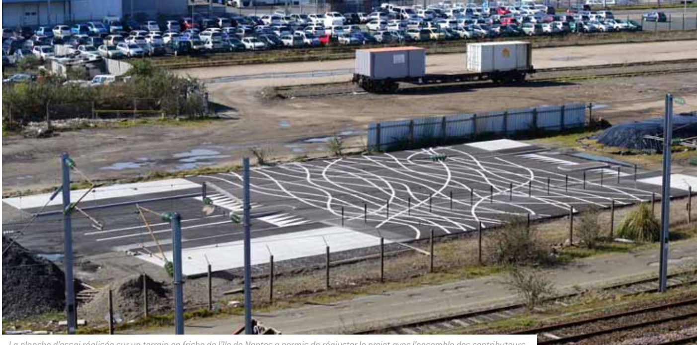
La planche d'essai réalisée sur un terrain en friche de l'île de Nantes a permis de réajuster le projet avec l'ensemble des contributeurs.
