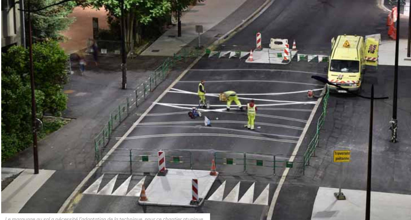
Le marquage au sol a nécessité l'adaptation de la technique, pour ce chantier atypique.
