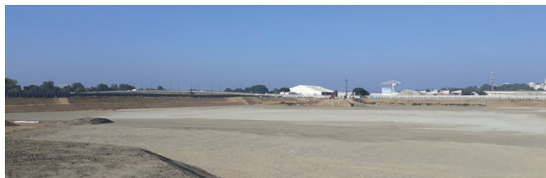
Après la phase de terrassement, le site du CHU est prêt à accueillir les premiers travaux.
